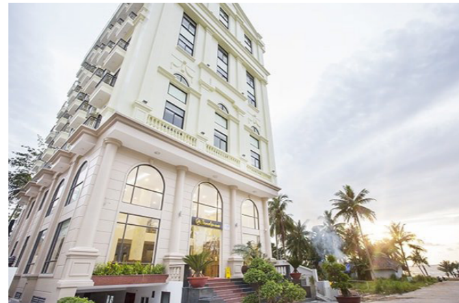
Khách sạn Sandy Địa chỉ: TT. Dương Đông, Tp. Phú Quốc, T. Kiên Giang Hạng mục: Hệ thống nước nóng năng lượng mặt trời & Heat pump
