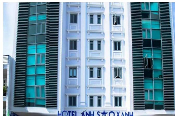
Hotel & Apartment Ánh Sao Xanh Địa chỉ: P. Phú Thạnh, Q. Tân Phú, Tp. Hồ Chí Minh Hạng mục: Hệ thống nước nóng năng lượng mặt trời
