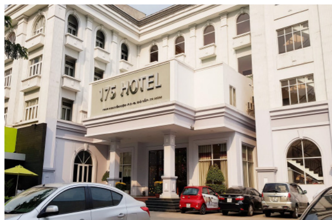
Khách sạn 175 Địa chỉ: P. 3, Q. Gò Vấp, Tp. Hồ Chí Minh Hạng mục: Hệ thống nước nóng năng lượng mặt trời
