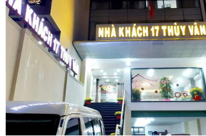
Nhà Khách Chính Phủ Địa chỉ: 17 Thùy Vân, Tp. Vũng Tàu, T. Bà Rịa Vũng Tàu Hạng mục: Hệ thống nước nóng năng lượng mặt trời
