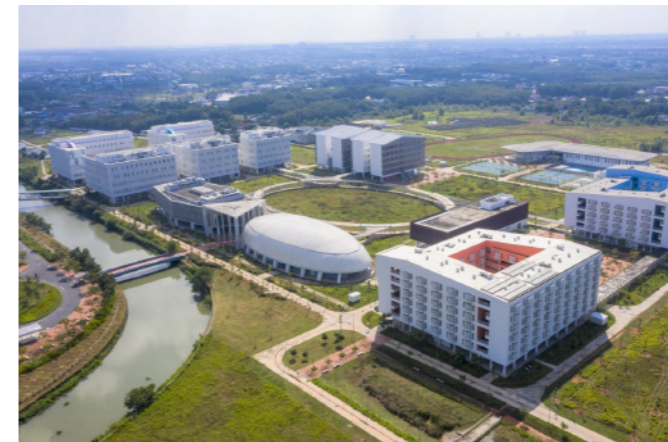
Trường Đại học Việt Đức Địa chỉ: P. Thới Hòa, Tx. Bến Cát, T. Bình Dương Hạng mục: Hệ thống nước nóng năng lượng mặt trời
