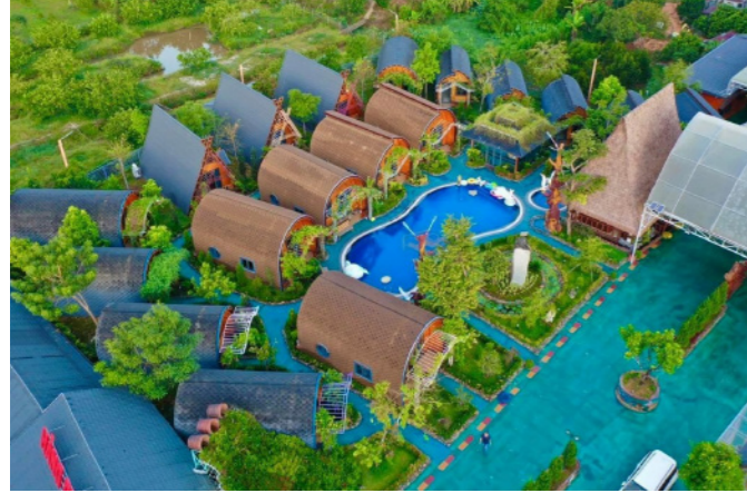
Resort Hàng Dương Địa chỉ: X.Hà Lâm, H. Đa Hòa, T. Lâm Đồng Hạng mục: Hệ thống nước nóng năng lượng mặt trời & Heat Pump
