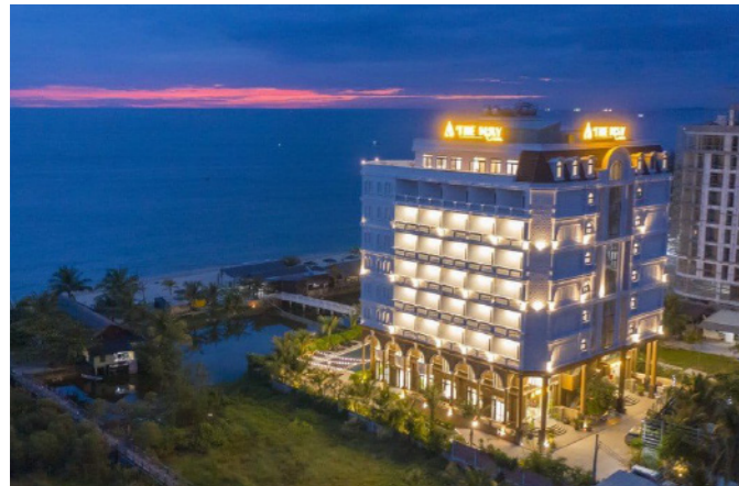
Khách sạn The May Địa chỉ: TT. Dương Đông, Tp. Phú Quốc, T. Kiên Giang Hạng mục: Hệ thống nước nóng năng lượng mặt trời & Heat pump
