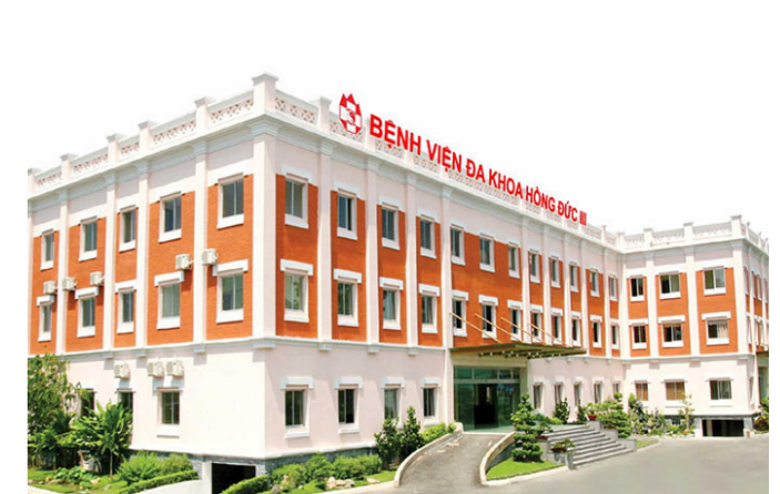
Hệ thống Bệnh viện Hồng Đức Địa chỉ: Hệ thống bệnh viện Hồng Đức II & III Hạng mục: Hệ thống nước nóng Heat pump & Hệ thống lọc RO
