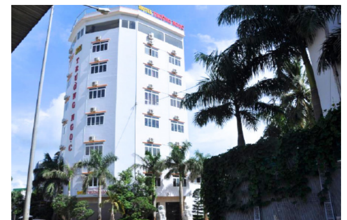
Khách sạn Trương Ngọc Đắc Lăk Địa chỉ: P. Tân Lợi, Tp. Buôn Ma Thuột, T. Đắk Lắk Hạng mục: Hệ thống nước nóng năng lượng mặt trời & Heat Pump
