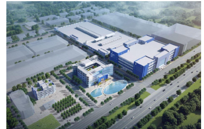
Nhà máy dệt Top Textile Địa chỉ: KCN Dệt may Rạng Đông, T. Nam Định Hạng mục: Hệ thống xử lý nước sạch
