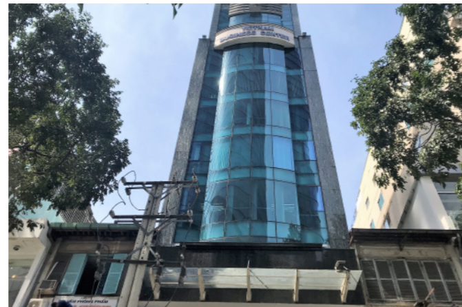
Tòa nhà 57-59 Phó Đức Chính Địa chỉ: 57-59 Phó Đức Chính, Q.1, Tp. Hồ Chí Minh Hạng mục: Hệ thống nước nóng năng lượng mặt trời
