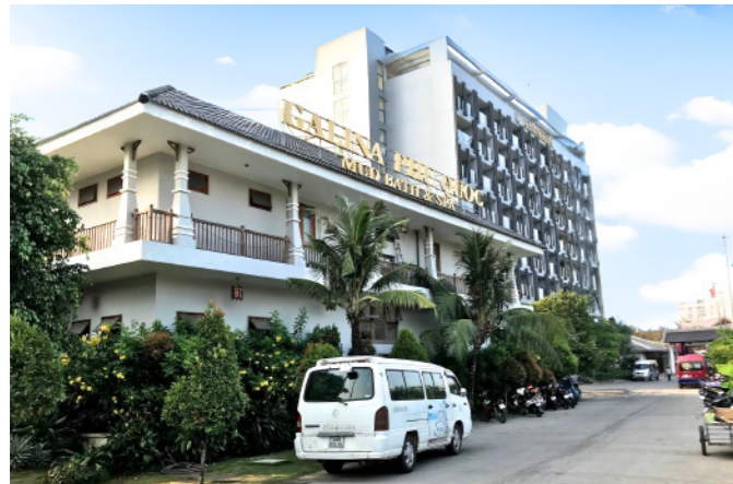
Resort Galina Phú Quốc Địa chỉ: X. Dương Đông, Tp. Phú Quốc, T. Kiên Giang Hạng mục: Hệ thống nước nóng năng lượng mặt trời & Heat pump
