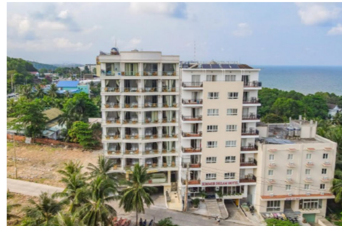
Khách sạn Home Park Phú Quốc Địa chỉ: TT. Dương Đông, Tp. Phú Quốc, T. Kiên Giang Hạng mục: Hệ thống nước nóng năng lượng mặt trời & Heat pump, Hệ thống xử lý nước sạch
